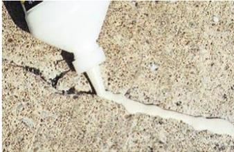
Se puede utilizar cola de rata por debajo del sellador de la grieta para controlar el uso de material.
