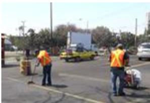
Permita que el sellador para pavimento de recién aplicación cure por lo menos 24 horas antes de aplicar la pintura para tráfico.
