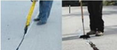
Los baches y oquedades de la superficie del pavimento se deben rellenar con una mezcla asfáltica apropiada aplicada en frío (Easy Patch™) o en caliente. **Deje secar de 30 a 40 minutos antes de aplicar el sellador de superficies ColorPave® Neutral Ready-mix.**
